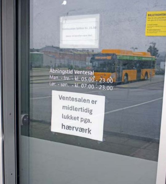
Abb. 10 Eingangstür des wegen Vandalismusschäden monatelang geschlossenen Warteraums am Busbahnhof in Apenrade
