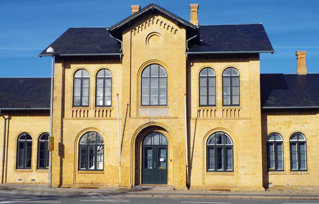
Abb. 5 Bahnhofsgebäude aus den 1860er Jahren in Apenrade, der Schienenstrang wird nur noch saisonal für den Fahrraddraisinenbetrieb genutzt
