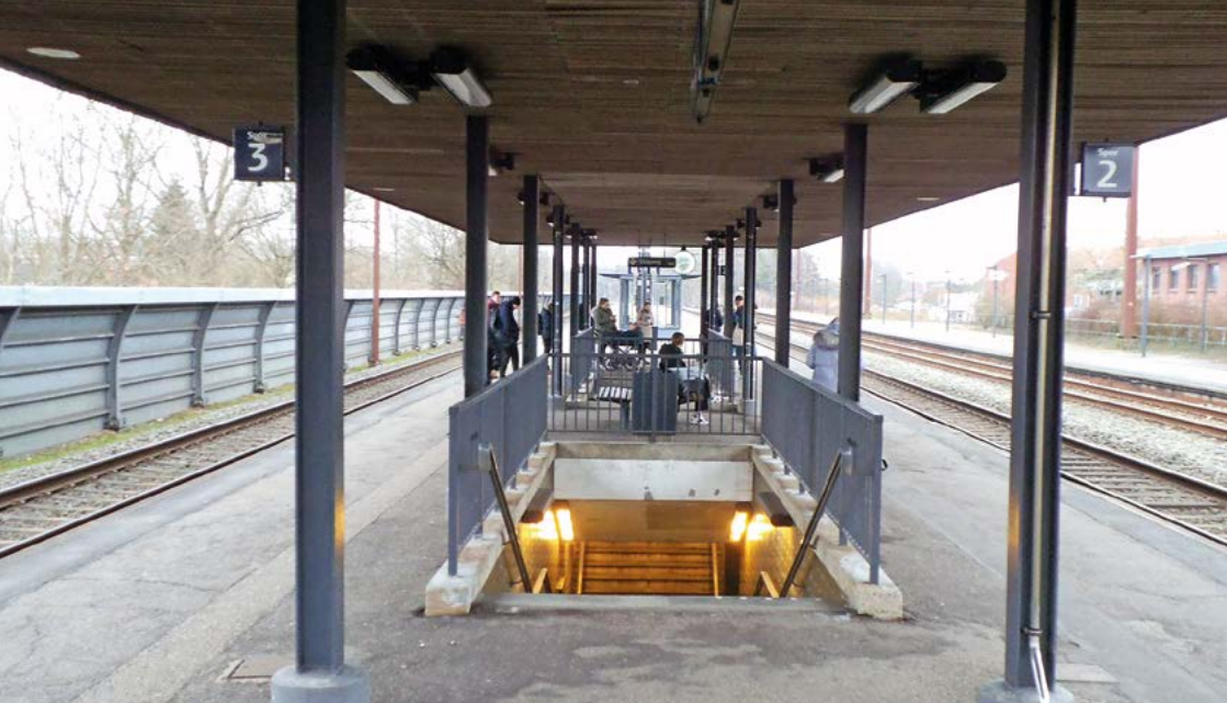
Abb. 8 Nicht barrierefreier Zugang zum Fernbahnsteig in Rothenkrug, einer Station mit großem Einzugsgebiet an der international wichtigen östlichen Nord-Süd-Hauptstrecke
