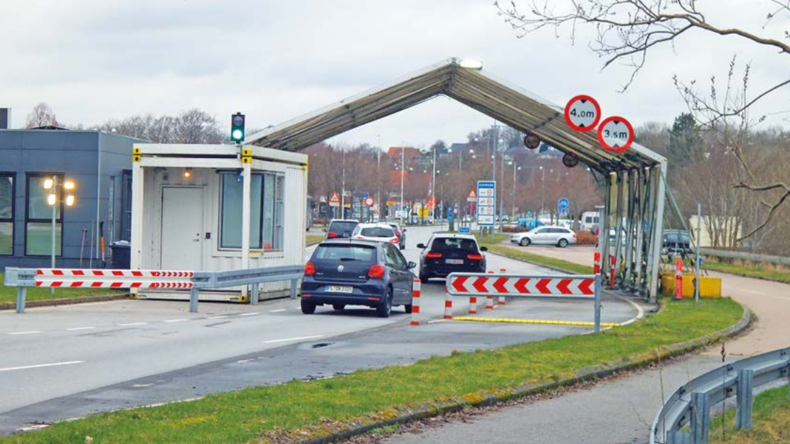
Abb. 1 Zeltdurchfahrt mit Spurverengung am Grenzübergang Kupfermühle-Krusau
