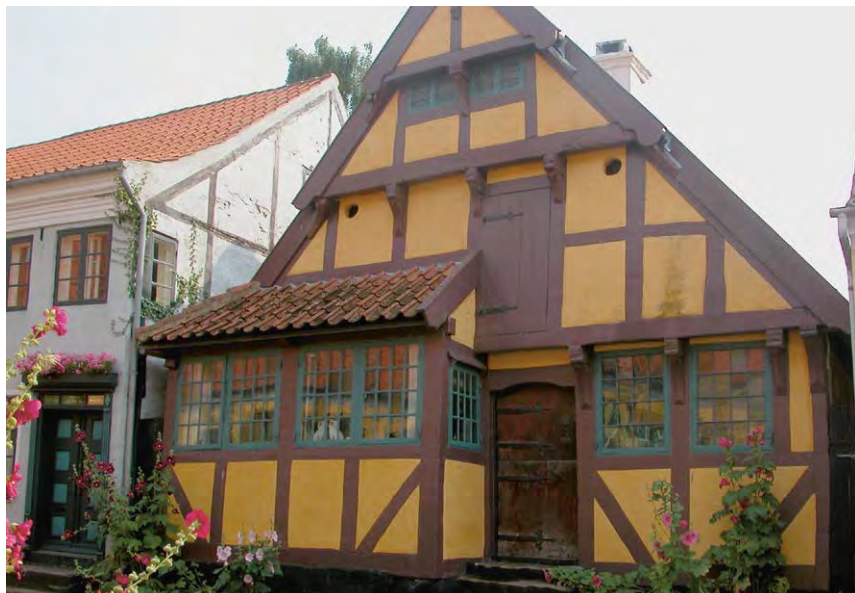
Abb. 7 Das 1690 erbaute „Priors Hus“ in der Søndergade im malerischen, von engen Gassen und denkmalgeschützten Fachwerkhäusern gekennzeichneten Ærøskøbing ist das älteste Haus der Stadt
