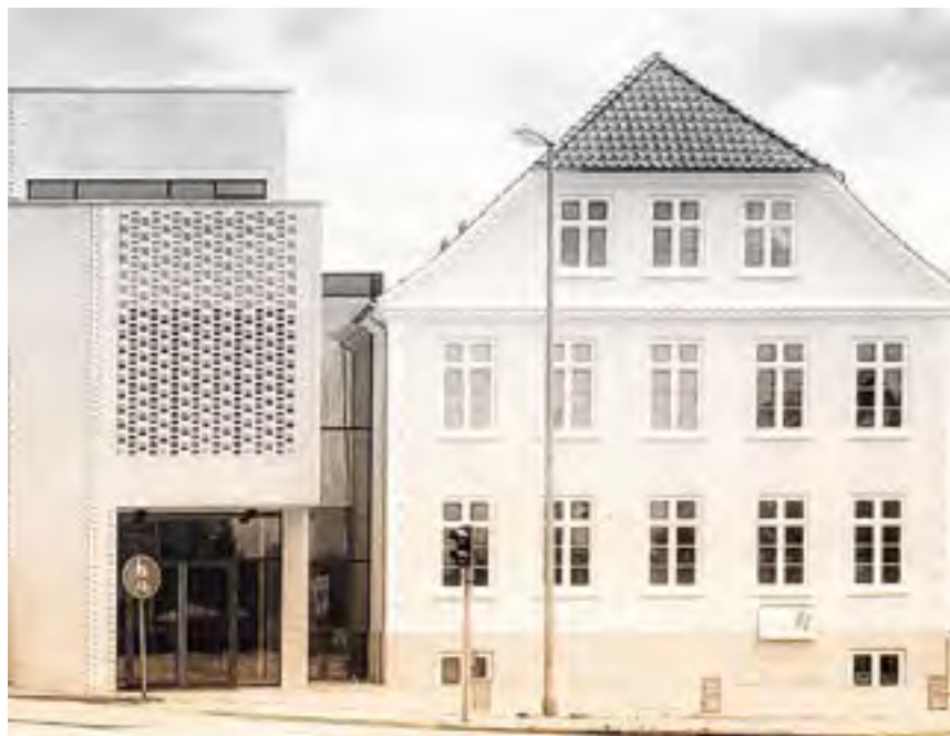
Abb. 5 Ansicht des Deutschen Museums für Nordschleswig mit dem neuen Haupteingang
