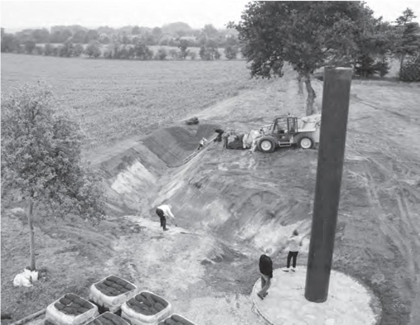
Abb. 4 Verlegen eines Rollrasens zur Sicherung der Gräbenwände vor Erosion. Im Vordergrund die Stele von Ansgar Nierhoff
