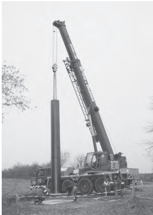
Abb. 3 Fachgerechte Platzierung der 7,5 m hohen und 29 t schweren Stele in Ladelund, 10.11.2010
