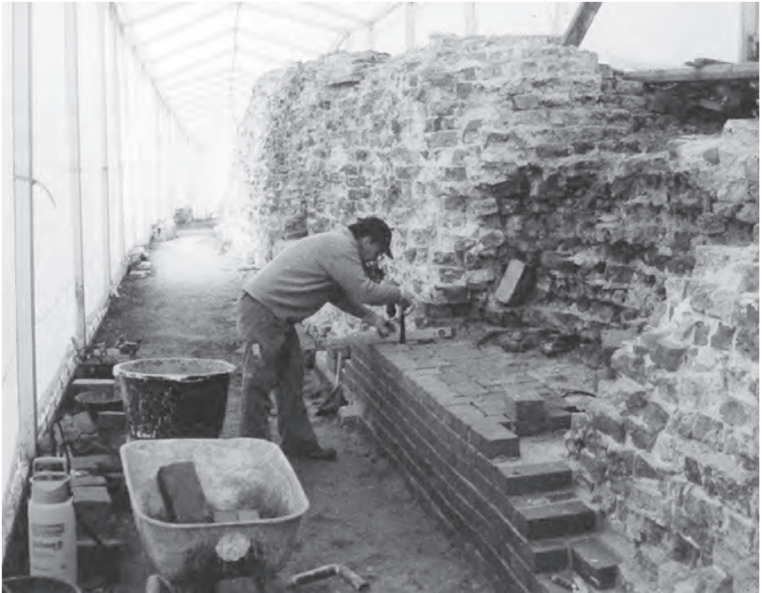
Abb. 2 Sanierungsarbeit an der mehr als 800 Jahre alten Mauer des Danewerks
