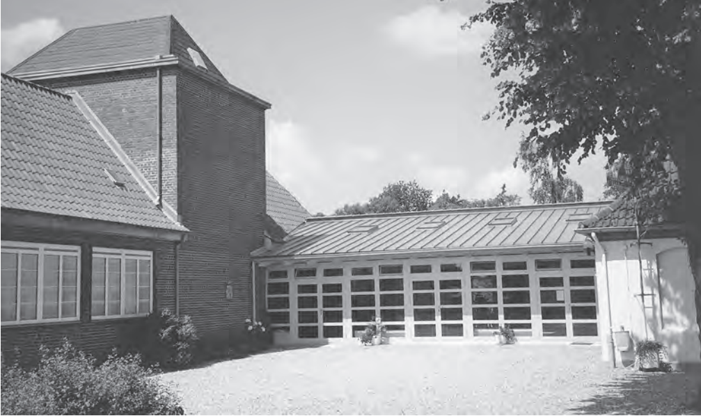
Abb. 4 Der vom Architekten des Kreises Schleswig-Flensburg Willi Jühnke gestaltete Verbindungsbau zwischen „Gedächtnishalle“ (l.) und Gaststätte (früher Waffenkammer) mit Platz für Sonderausstellungen, Mai 2005
